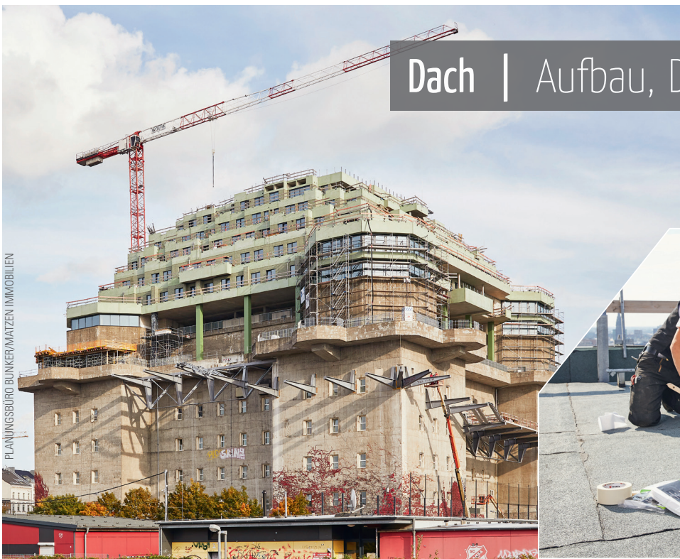
Der Grüne Bunker wurde vor der Bepflanzung abgedichtet.
