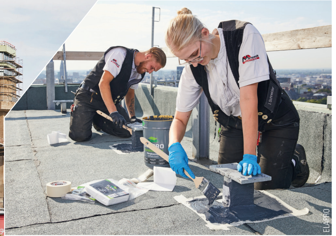
Seit der Verwendung für die aufwendigen Abdichtungen am grünen Bunker St. Pauli verwendet die Dachdeckerei Marquardt »Elapro 1k-SIL« bei allen ihren Bauprojekten.
